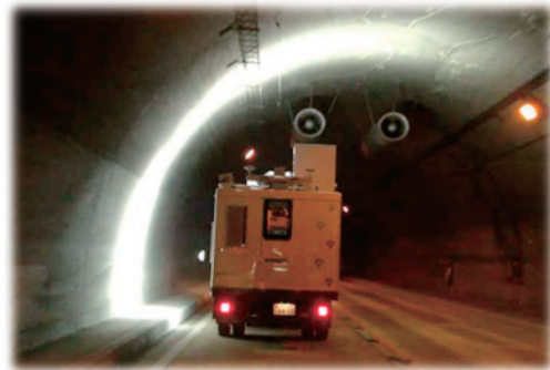
図1 トンネル覆工撮影点検
