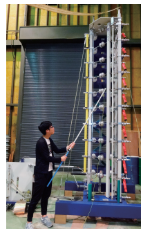
▲1000kV雷インパルス 電圧発生器
