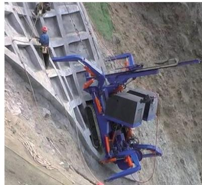
図は法面での削孔作業の様子である。ロボットは地形に適応して脚を駆動することで自重を支え、歩行および各種作業動作が可能である。
