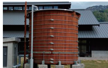
図2 漆塗木槽(白山麓キャンパス)
