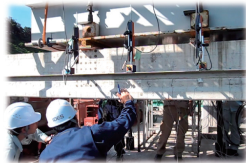
図1 石炭灰を有効利用した橋げたの載荷試験
