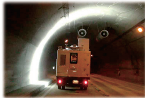
図1 トンネル覆工撮影点検
