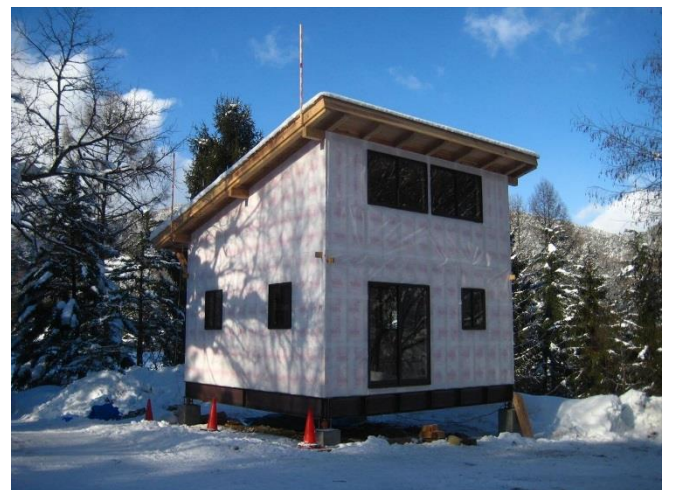
写真 10 2階壁面の完成（所用時間約 1 時間半）
