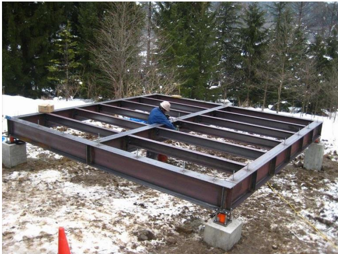
写真 6 試験体基礎の鉄骨
