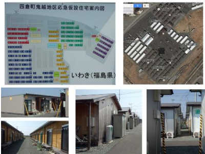
図 26 同一団地内で複数の種類の仮設住宅が建設された事例（いわき市）（2015年3月撮影）
