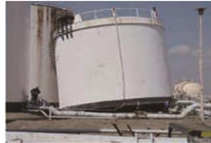
写真 1. タンクの浮き上がり 1)
