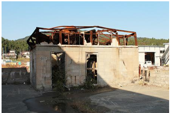
図 7 郵政宿舎北側の焼けた倉庫
