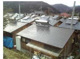
図 21 住田町の木造・戸建の仮設住宅（屋根に太陽熱温水器）（2013年12月撮影）
