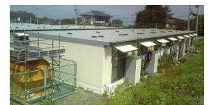
図18 仮設住宅の底(陸前高田)(2013年8月撮影)
