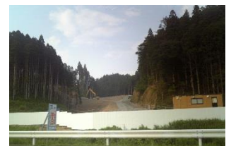
図16 沿岸部の山沿いでは災害公営住宅の建設に向けた宅地開発が進んでいる(南三陸)(2013年8月撮影)
