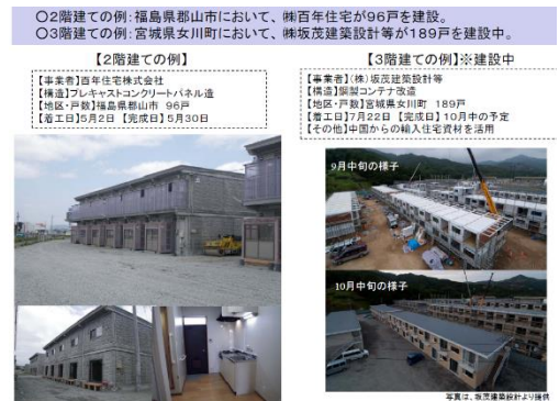
図 28 2,3階建ての仮設住宅（左：郡山、右：女川） 37)
