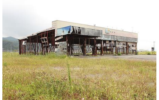
図 5 焼けた薬王堂の建物（鹿折地区）
