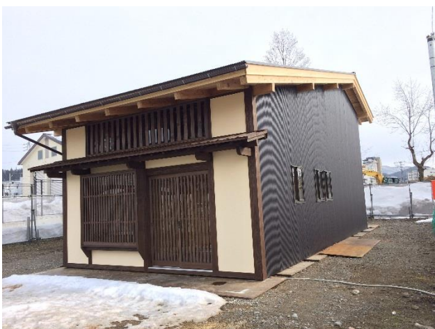
写真 12 モデルハウス前掲 (白い壁部分が今回開発した壁である)
