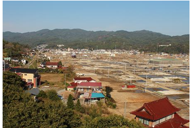
図 3 気仙沼市鹿折地区の現況（2012. 10. 22 撮影）
