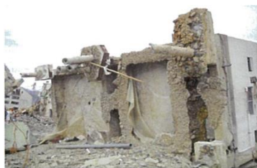
図 2. 2011 年の東北地方太平洋沖地震における地盤の液状化と巨大津波の連動作用によると推測される被害例 (出典：日本建築学会調査速報, 2011,7)
