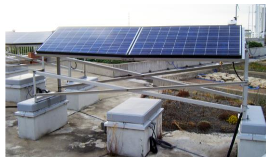
図9 30°南傾斜面に設置した日射計と太陽光発電パネル
