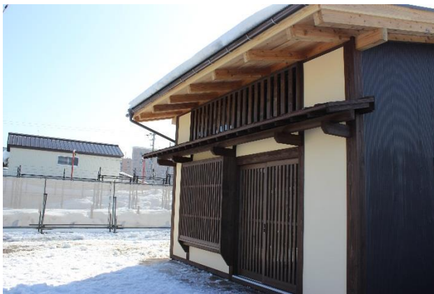
写真 11 モデルハウス前掲 (白い壁部分が今回開発した壁である)
