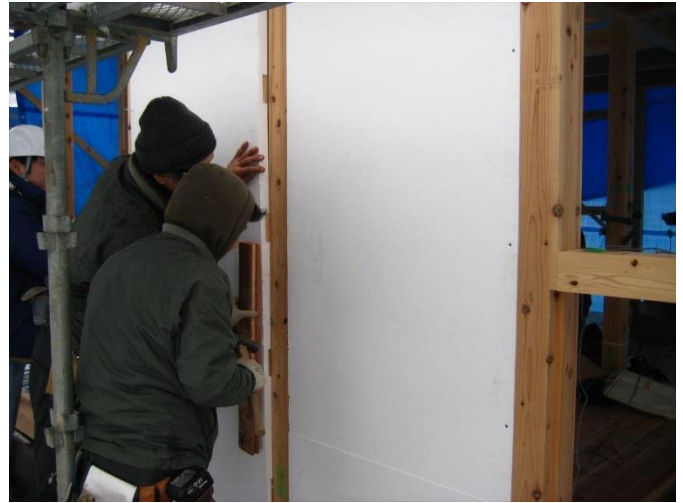
写真 8 壁パネルの設置状況
