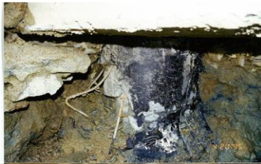
図 1. 1995 年の兵庫県南部地震における杭基礎の被害例
