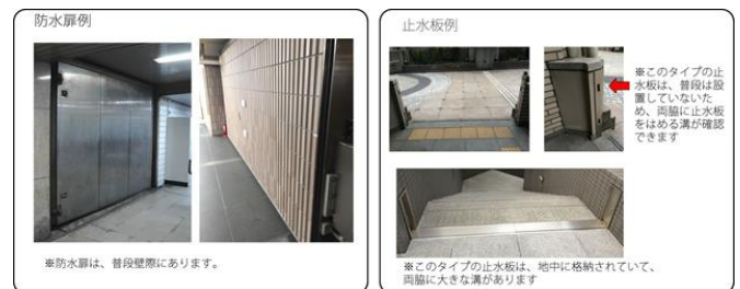
図 14 防水扉・止水板の設置例
