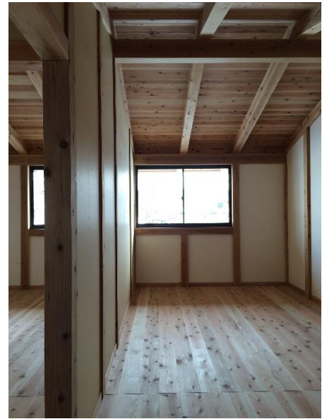
写真 13 モデルハウス前掲 (白い壁部分が今回開発した壁である)
