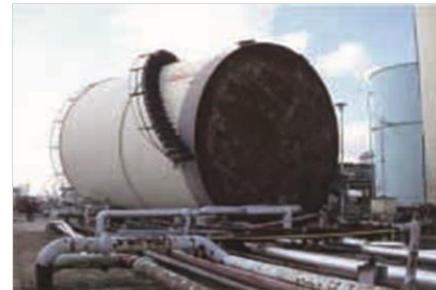
写真 2. タンクの転倒 1)
