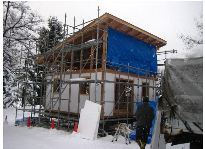
写真 9 1階壁面の完成（所用時間約 1 時間）
